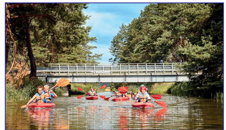
Mostki i kładki nie są tu przeszkodą dla kajakarzy
