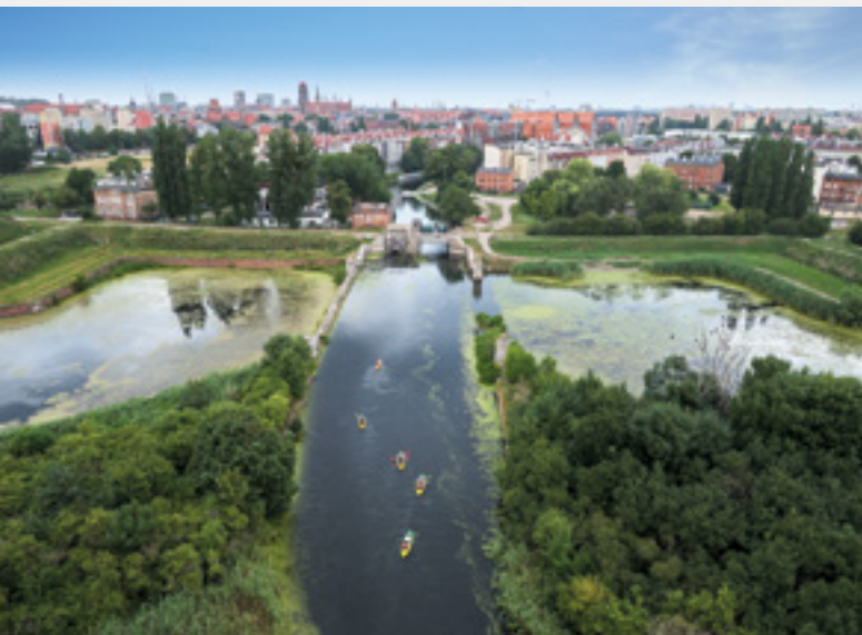
Kamienna Grodza Dam | Photo: Rafał Wojczal / szajewski.com.studio
