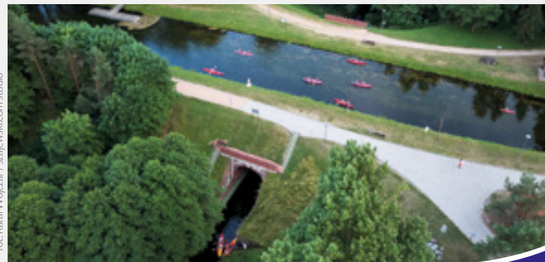
Fojutowo - akwedukt | fot. Rafał Wojczal / szajewski.com studio
