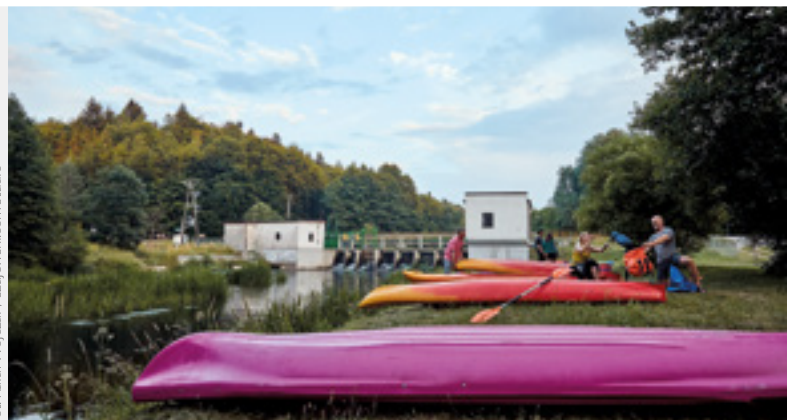
Elektrownia Łebień fot. Rafał Wojczal / szajewski.com.studio
